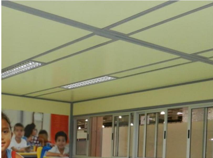
O painel de forro é constituído de placas poliméricas laminadas e o núcleo de Poliestireno Expandido EPS auto-extinguível tipo F1 com uma placa de gesso acartonado, com espessura final de 50 milímetros.
