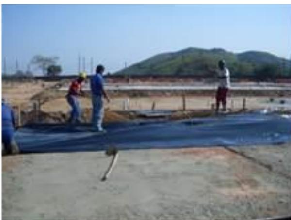
Montar a primeira armação em aço e tela de acordo com o projeto de forma e armação para radier, e concluir a execução do radier, conforme indicado no item 4.1.2.
