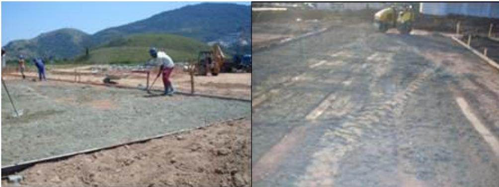
Distribuição da camada de bica corrida e nivelamento do piso.
