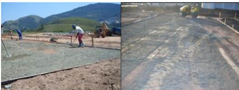
Após a distribuição da camada de bica corrida e nivelamento do piso posicionar as tubulações das instalações hidrossanitárias e o eletroduto de PVC rígido para a alimentação do quadro de distribuição elétrico, conforme projeto.
