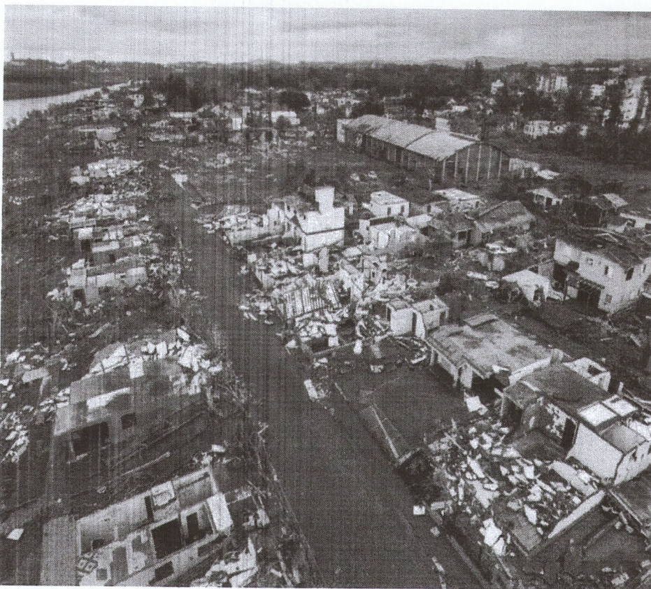
Destruição na cidade de Arroio do Meio, no Rio Grande do Sul — Foto: Gustavo Mansur/Palácio Piratini/ 19/05/2024
